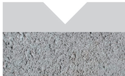
Detail povrchu novo položených dlažbových kameňov.
